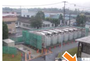
自家発電機撤去前
