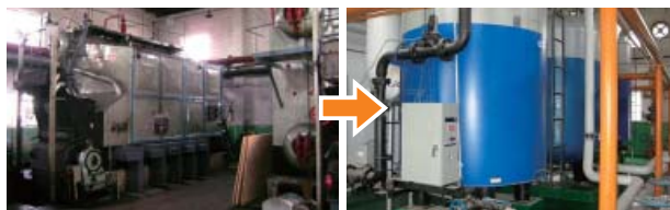
改造前:石炭ボイラー
