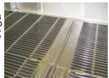
グレーチングの連結 (落下防止) Connecting gratings (Fall prevention)
